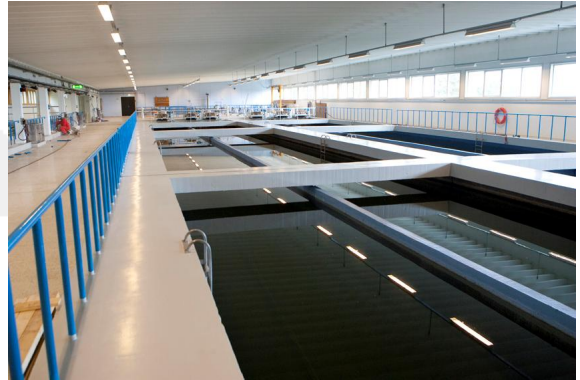
Nyoppusset produksjonshall vannverket
