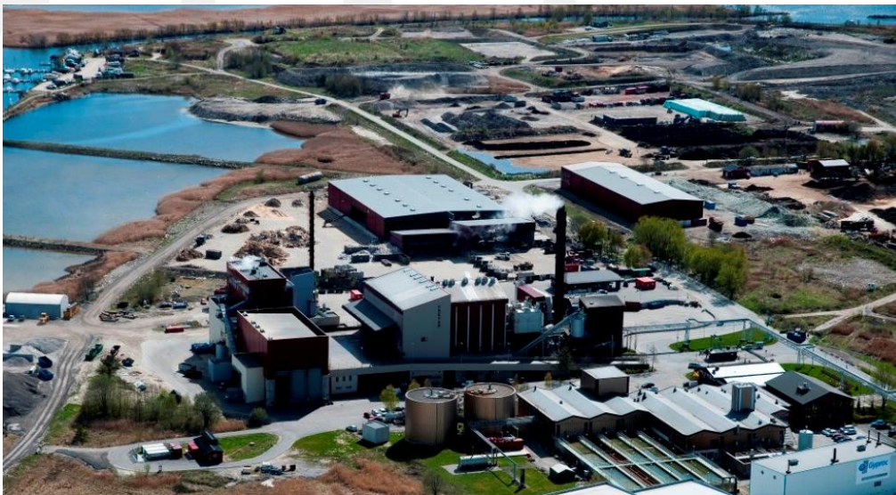
Flyfoto . avløpsrensaneanlegget i forgrunnen, energigjenvinningsanlegget, og bak områdene for slam- og massehandtering, samt deponiområdet.
