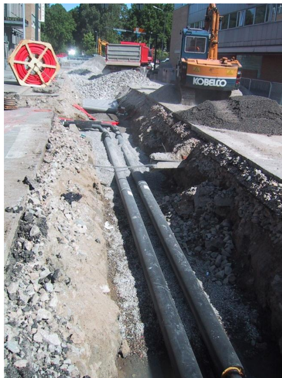
Bildet viser legging av fjernvarmerør.
