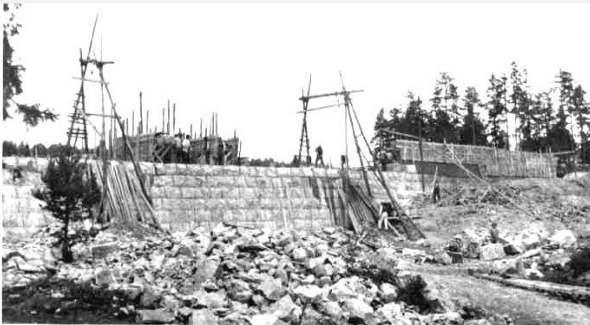
Bygging av Borredalsdammen, ca. 1907
