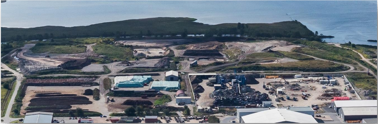
Deponiet mot sør
